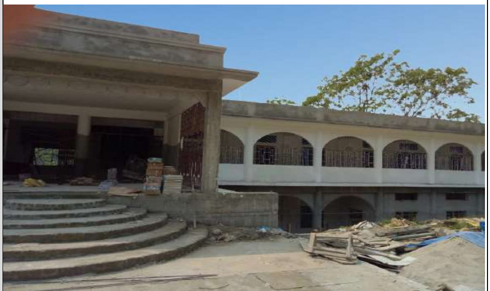
Bild oben: Baufortschritt der Schule am Anfang 2021
